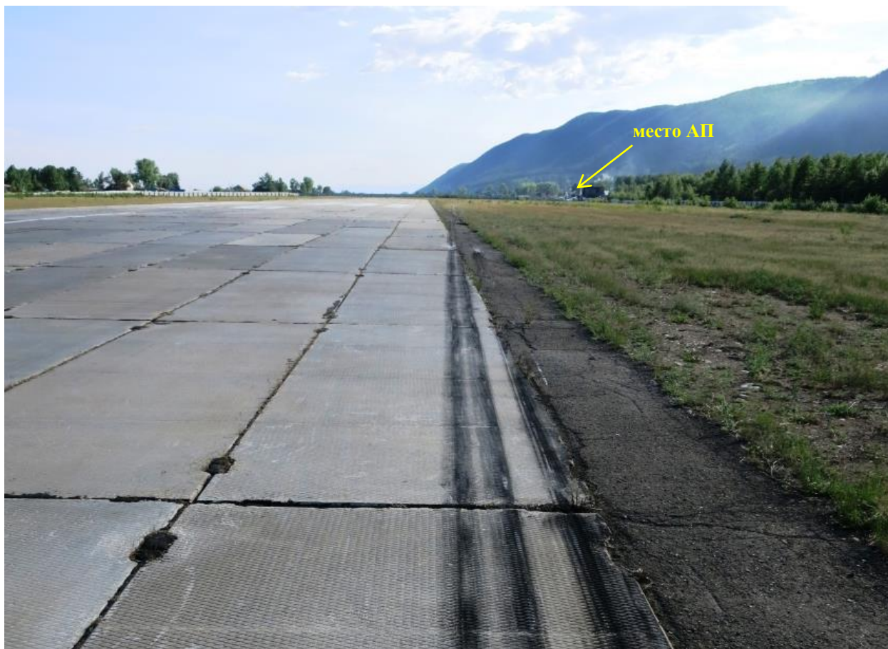
Рис. 11. Следы от шин правой основной стойки шасси при сходе с БВПШ на грунт
