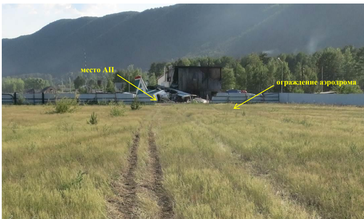
Рис. 14. Разрушенное ограждение аэродрома
